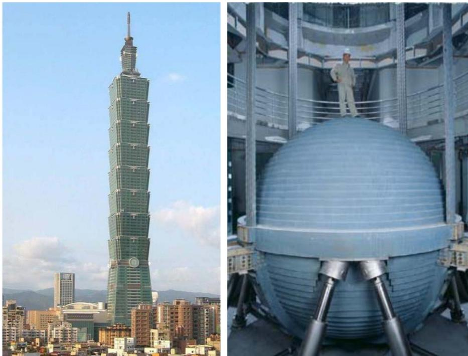
Figura 2.7: Edifício Taipei 101 em Taiwan e respectivo TMD instalado. Adaptado de (Moutinho, 2007)
